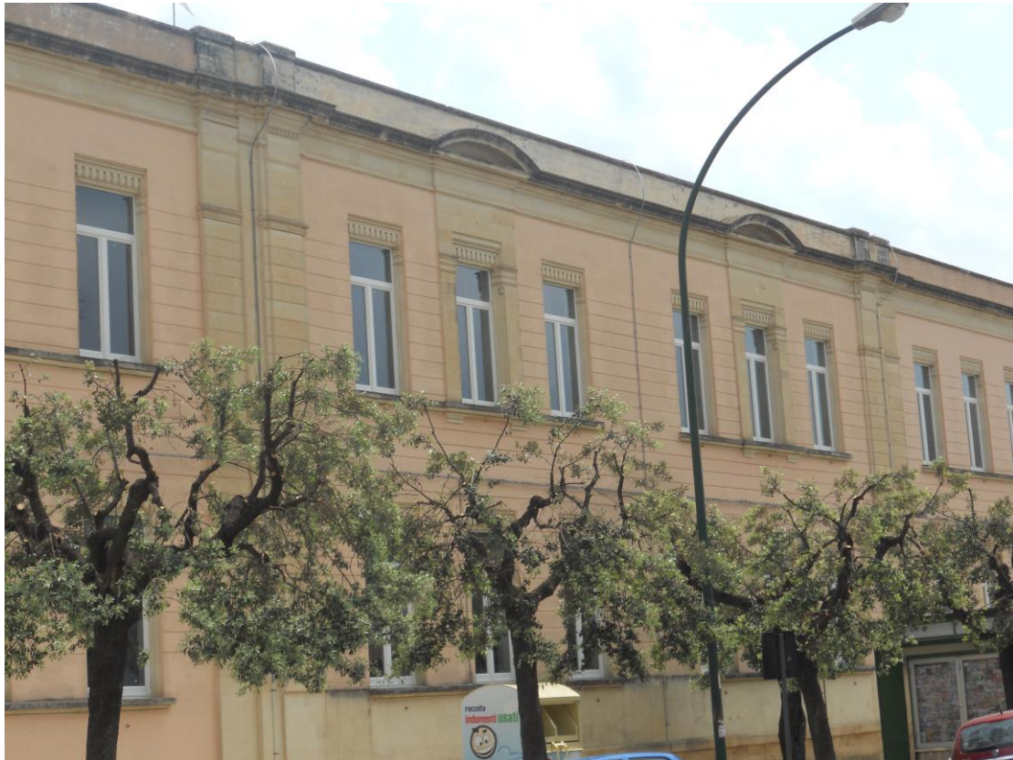
facciata principale su via G. Colaci
