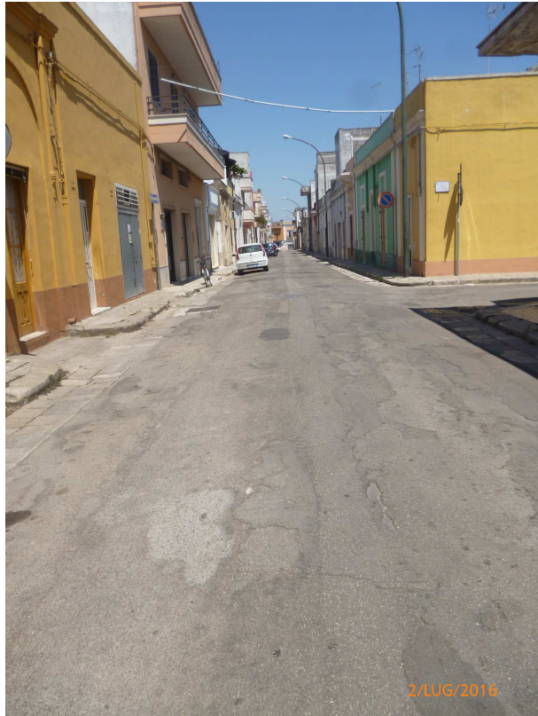
Foto n.36: VIA IV NOVEMBRE
