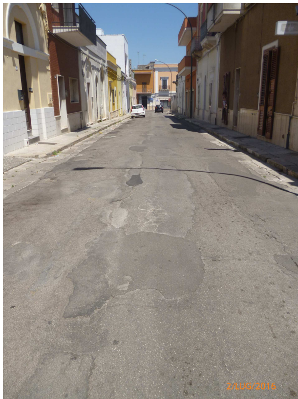
Foto n.37: VIA IV NOVEMBRE
