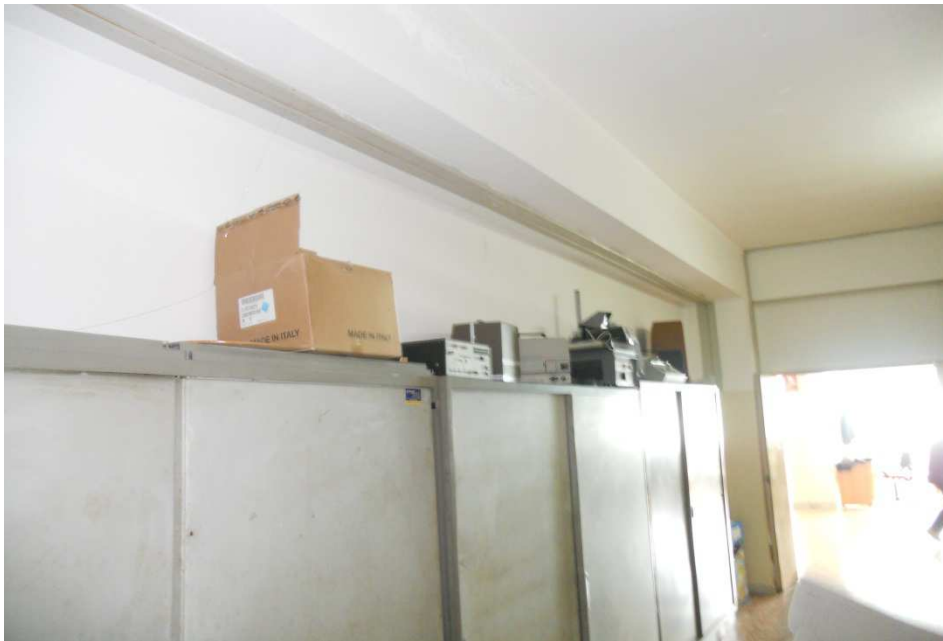
ancoraggio scaffalature e armadi
