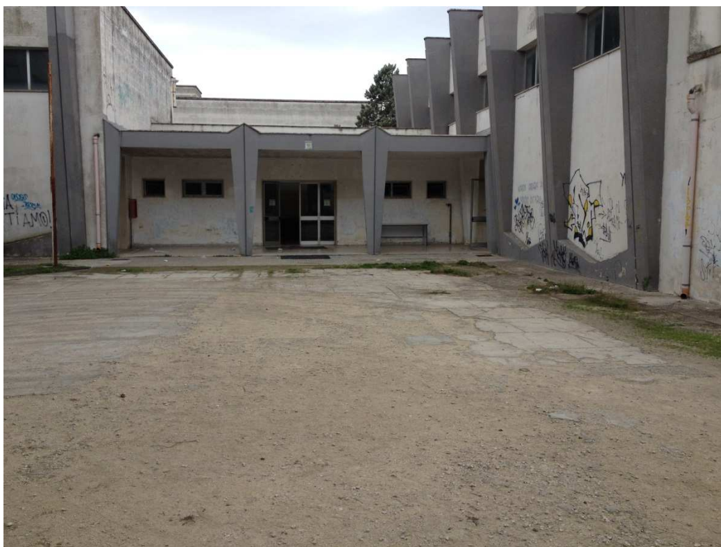
parte di piazzale esterno oggetto d'intervento
