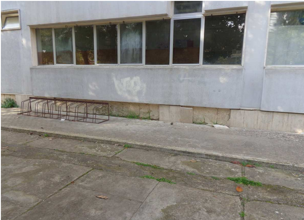
rimozione rivestimenti esterni
