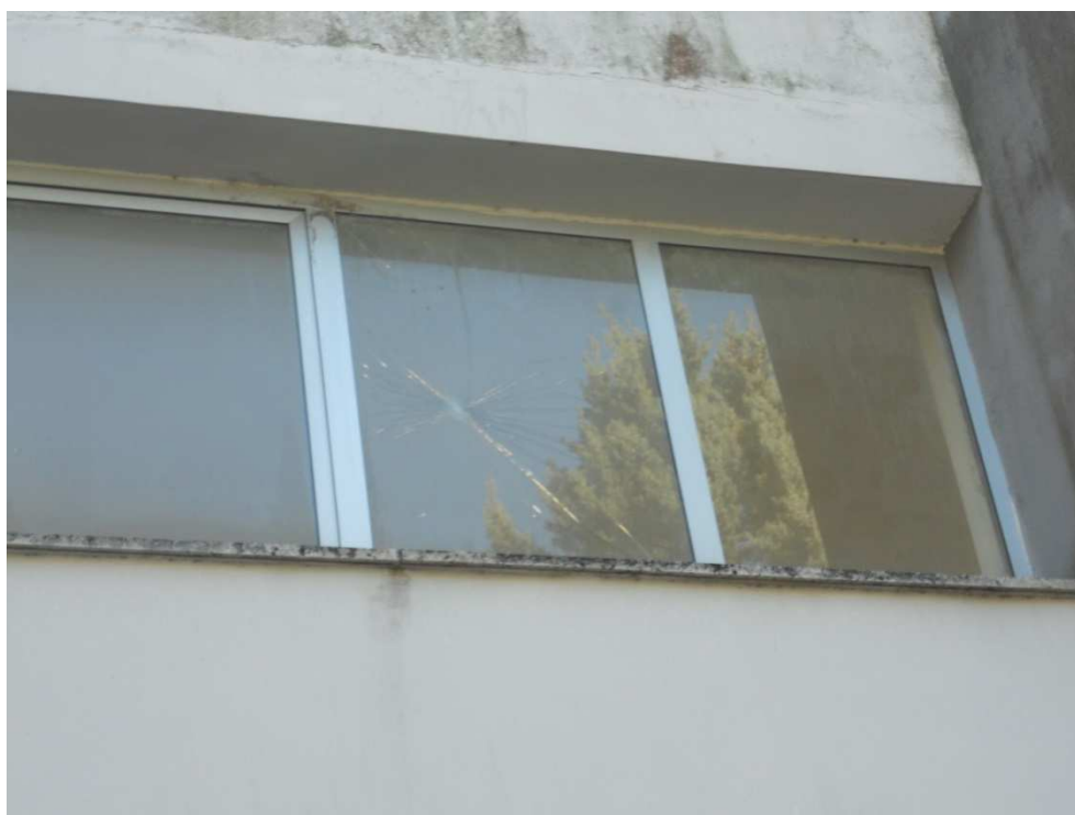
sostituzione lastre di vetro danneggiate
