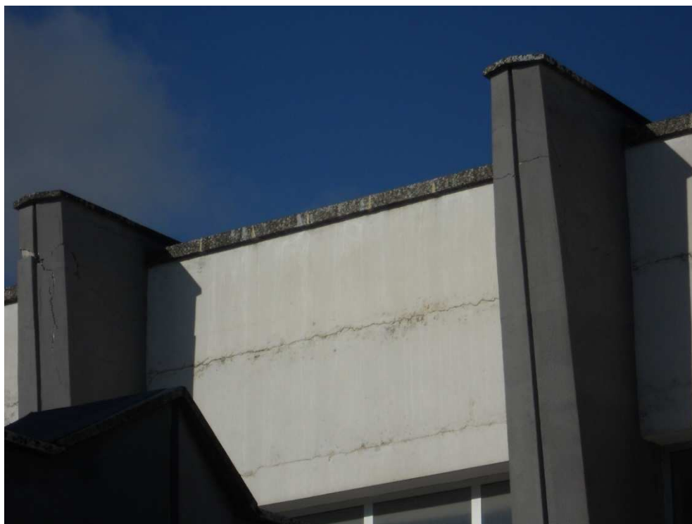
rifacimento copriferro esterno pilastri e travi – palestra
