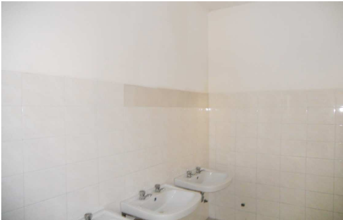
sostituzione rivestimenti interni servizi igienici
