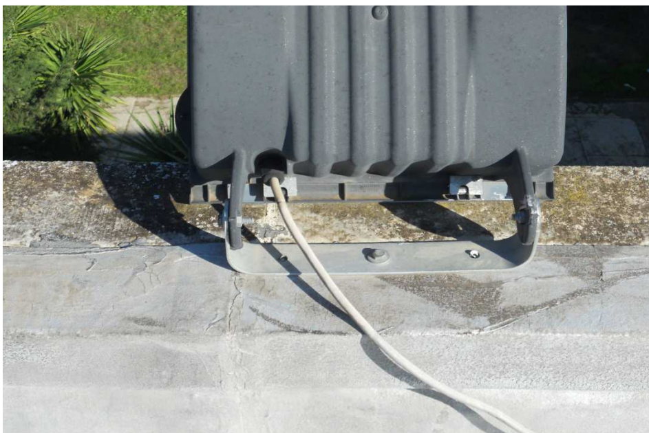
ancoraggio corpi illuminanti esterni
