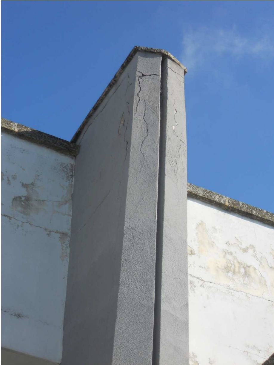
rifacimento coprifermo esterno pilastri e travi – palestra
