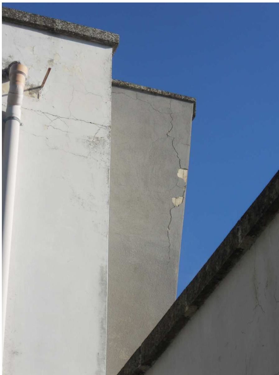
rifacimento copriferro esterno pilastri e travi – palestra
