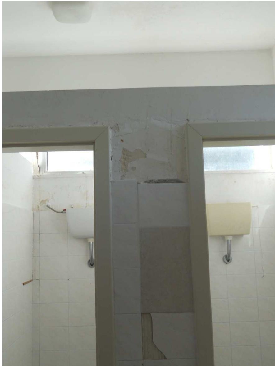
rifacimento rivestimenti servizi igienici
