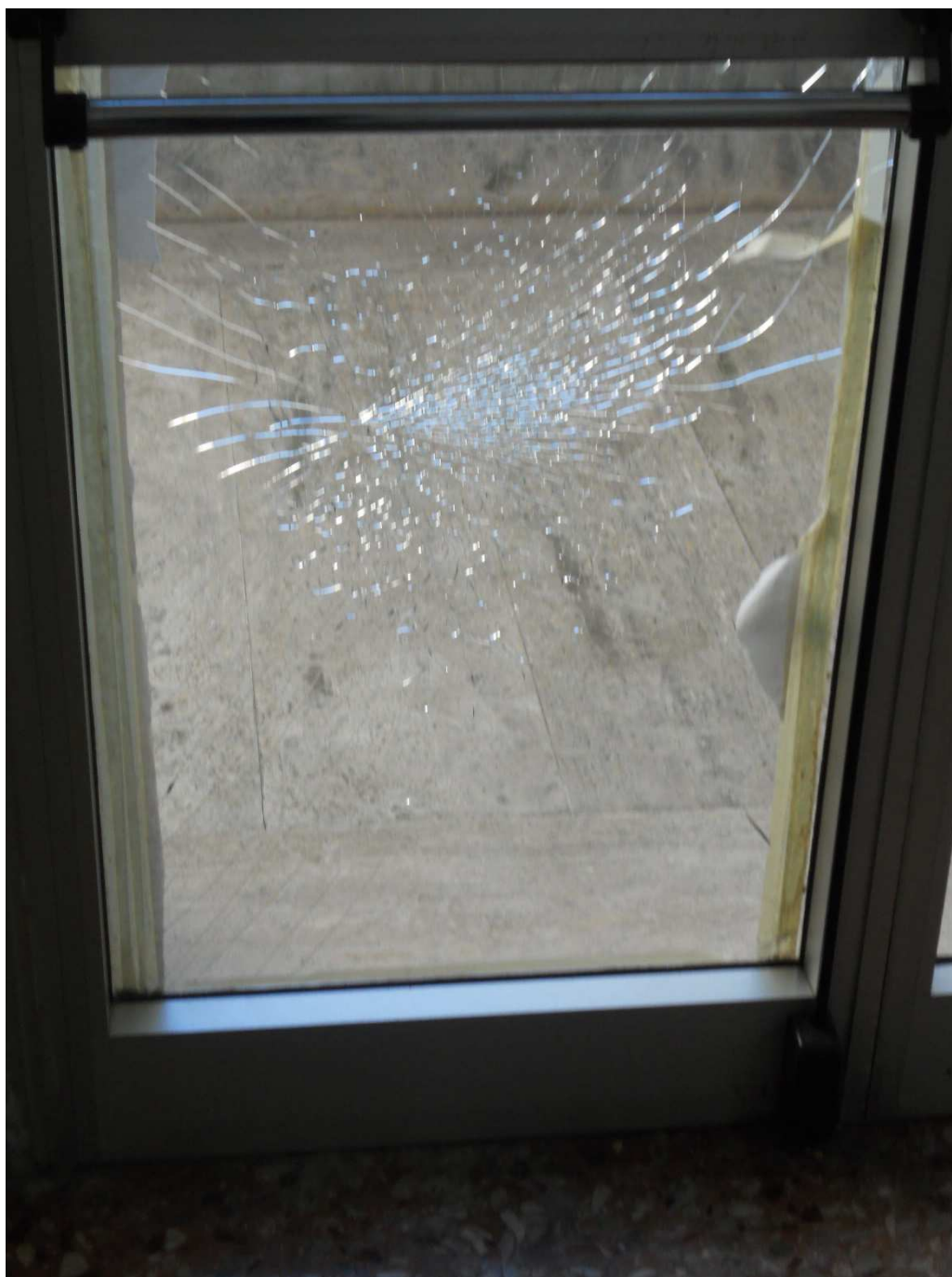
sostituzione lastre di vetro danneggiate
