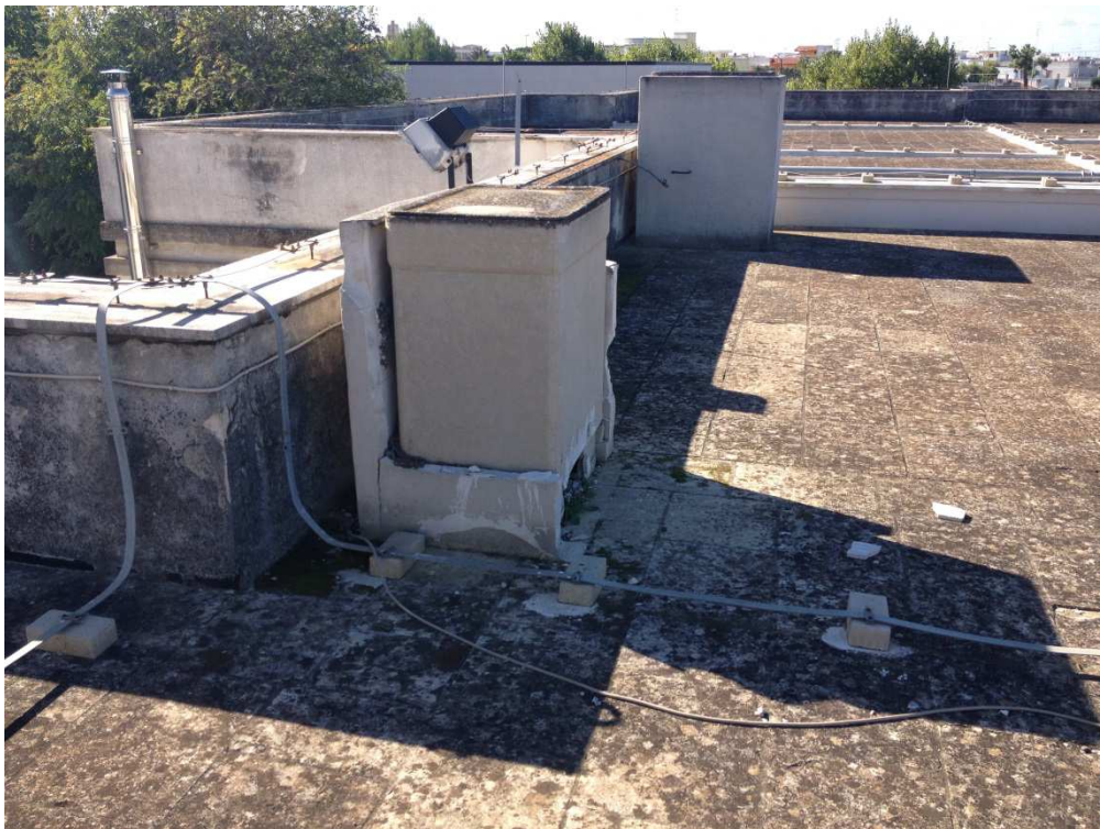
rimozione serbatoi in amianto
