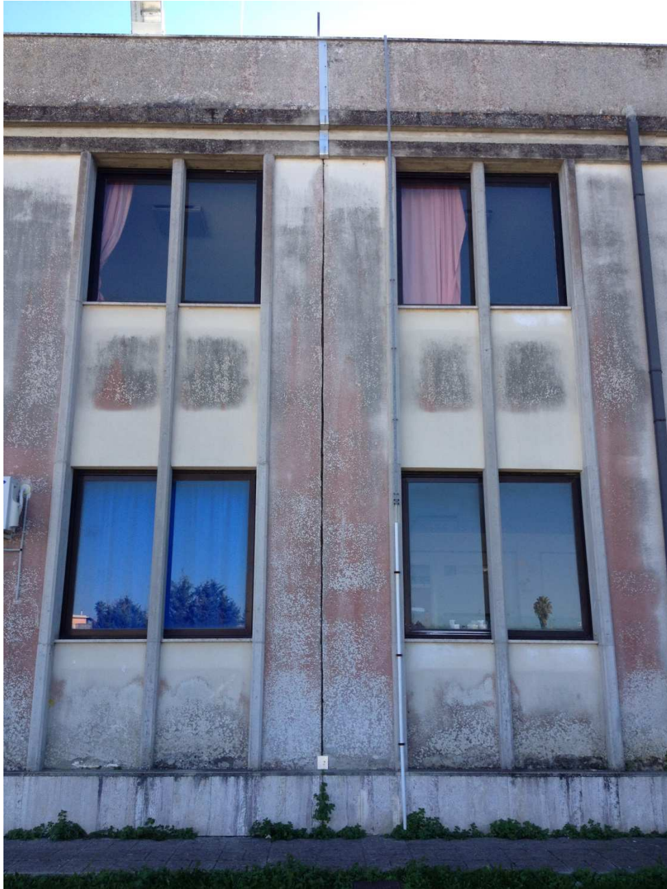
posa in opera di coprigiunto metallico
