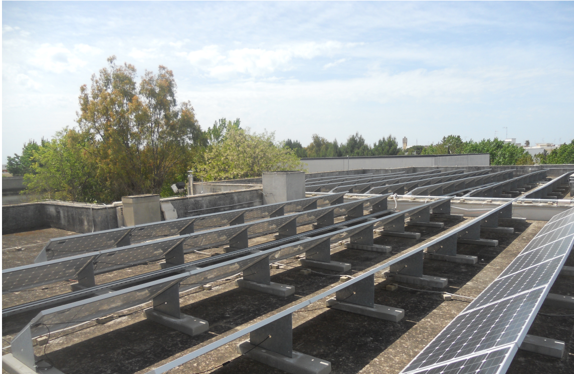
- Vista del lastrico solare di copertura con l'impianto fotovoltaico -
