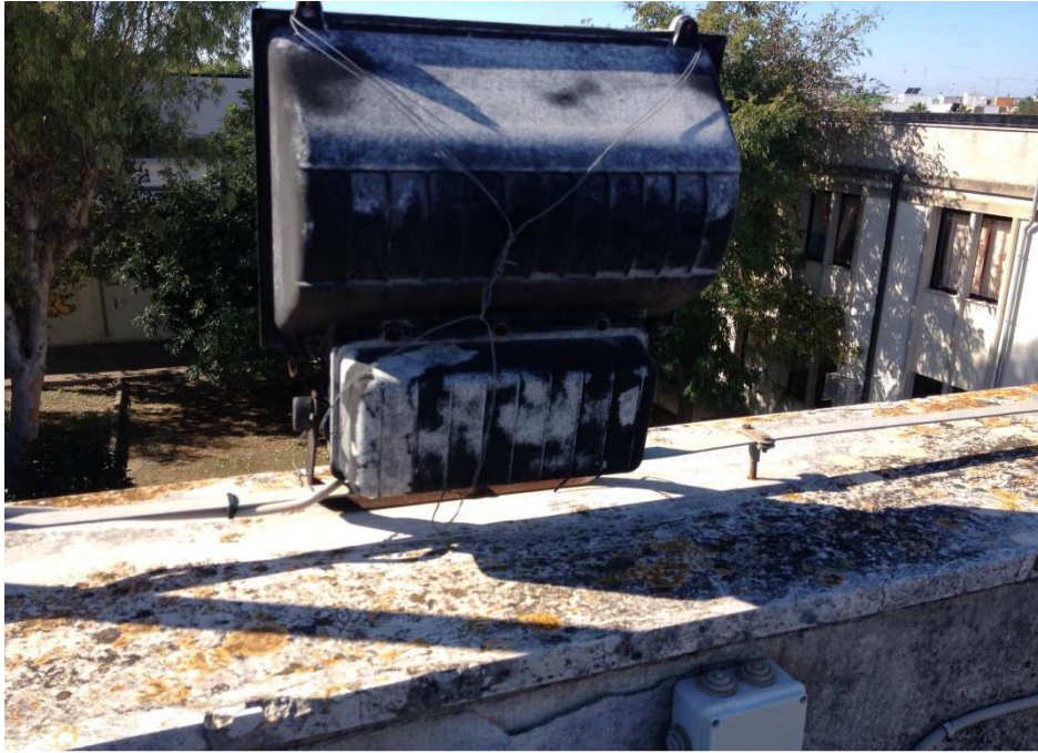
fissaggio fari esterni
