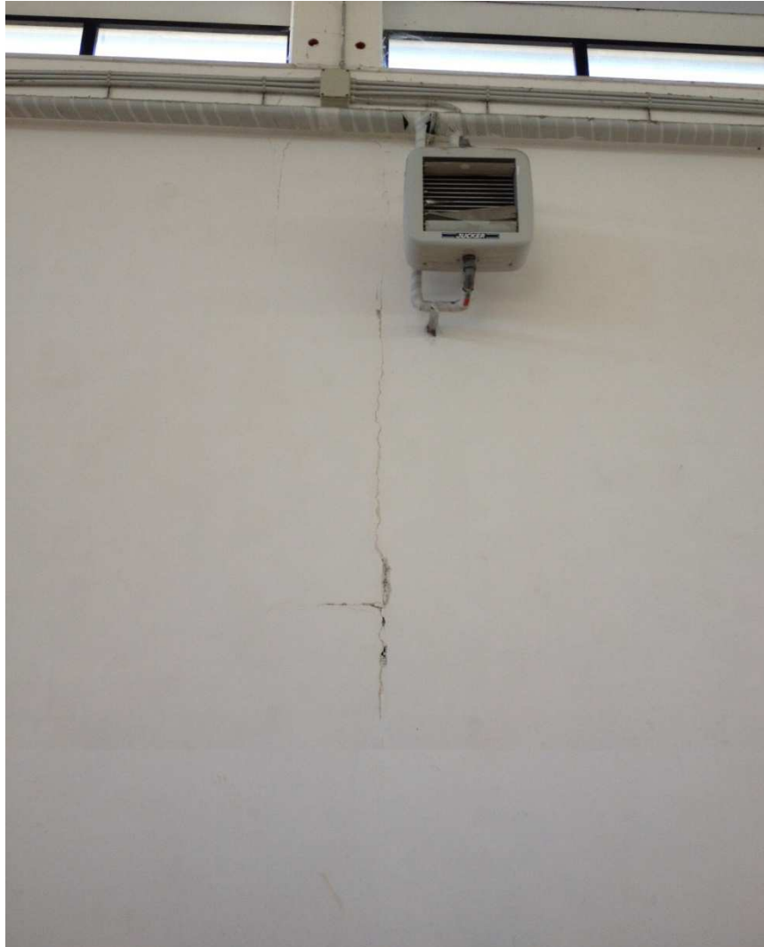
distacco di intonaci tra elementi strutturali
