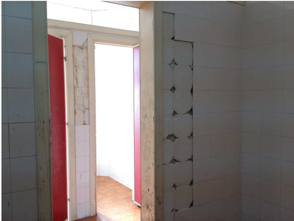
sostituzione rivestimenti interni
