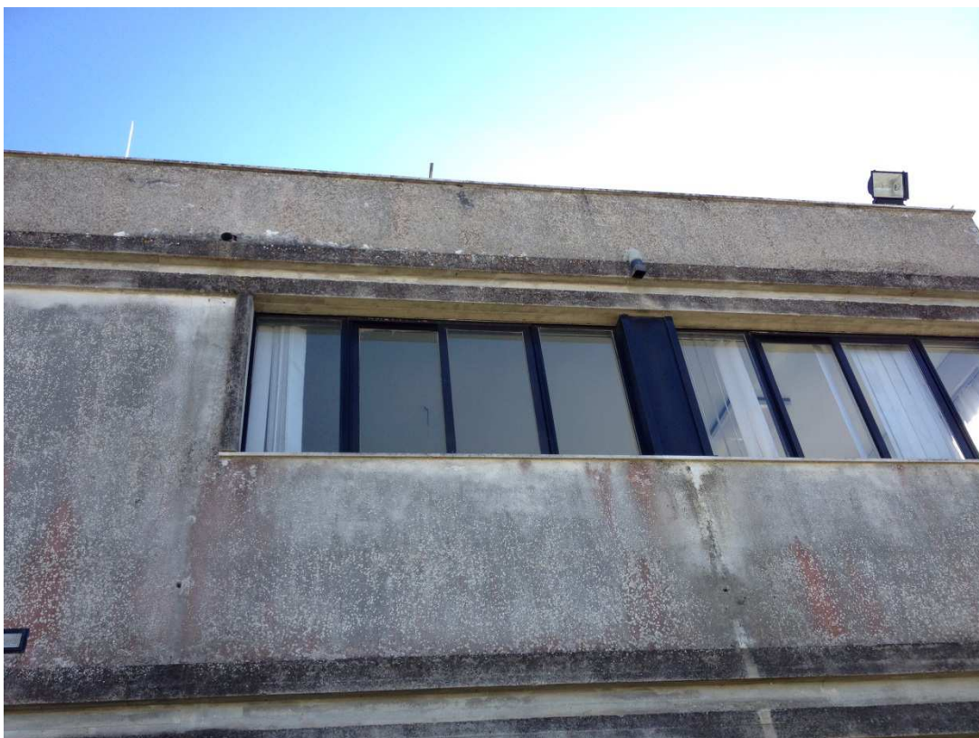
ripristino dei discendenti
