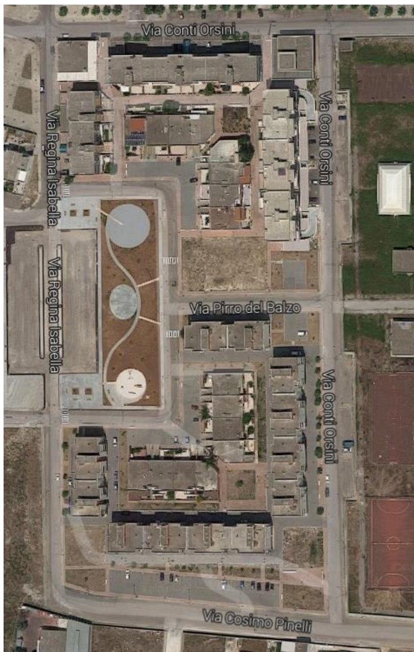
Figura 1 - Foto aerea Area d'Intervento
