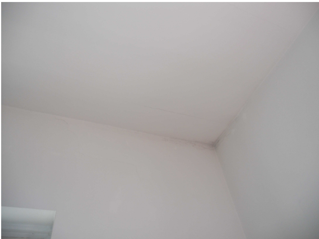
- Distacco di intonaci sulle pareti laterali e soffitto del Locale 10 -
