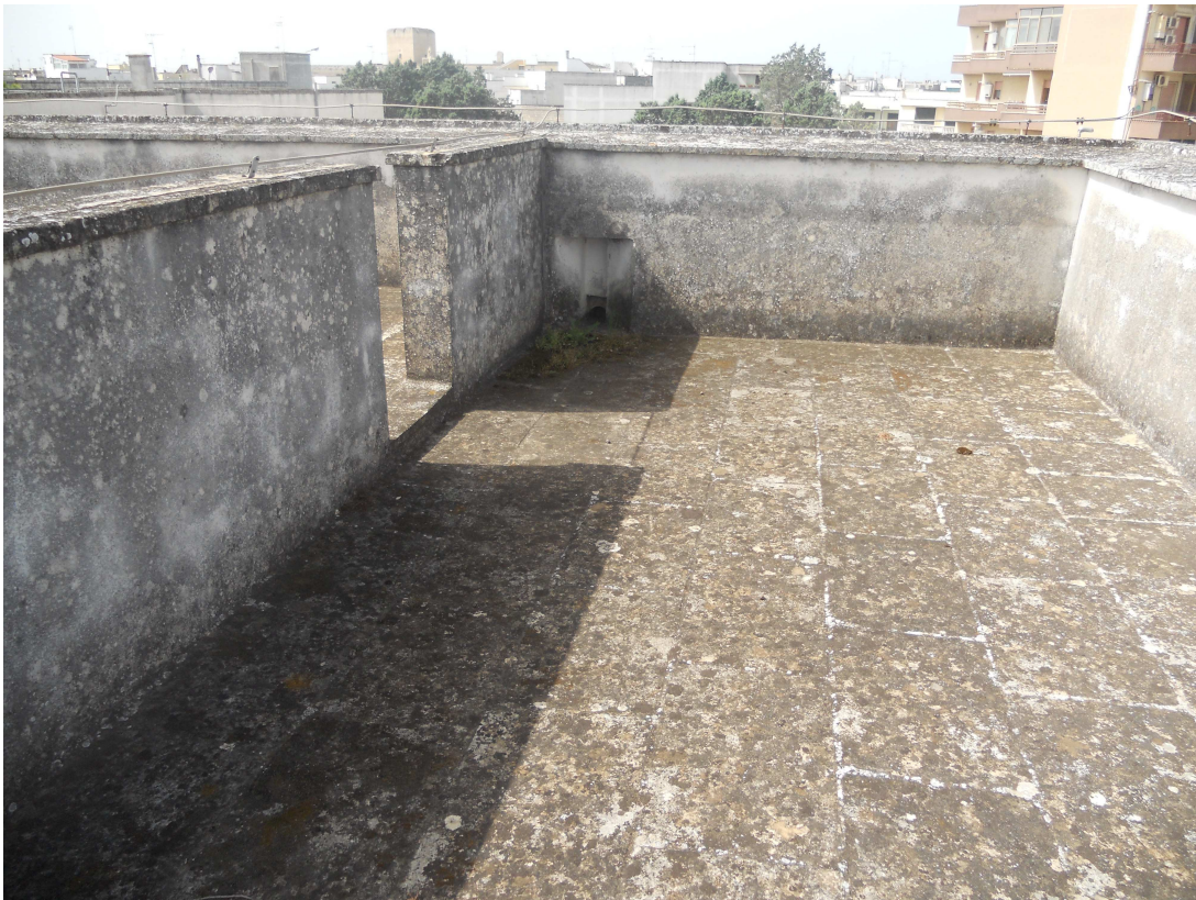
- Vista del lastrico solare di copertura da sistemare -
