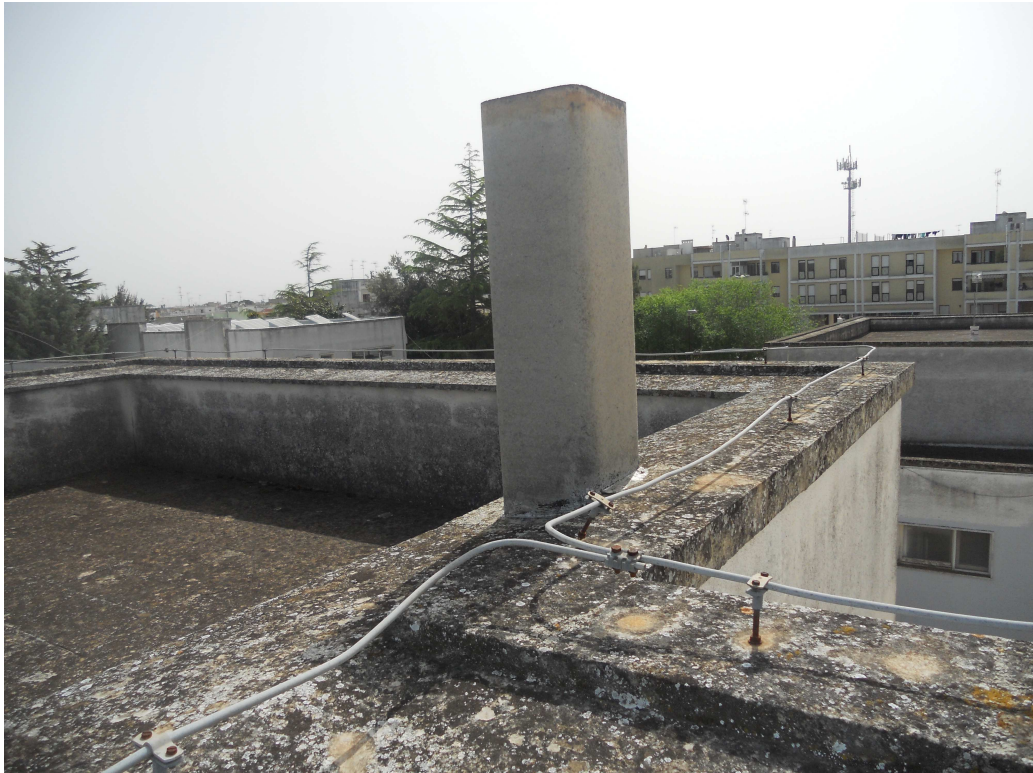
- Vista del comignolo in copertura da sistemare -
