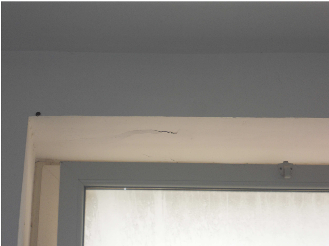
- Distacco di intonaci sulle pareti dei Locali 7-8-9 -
