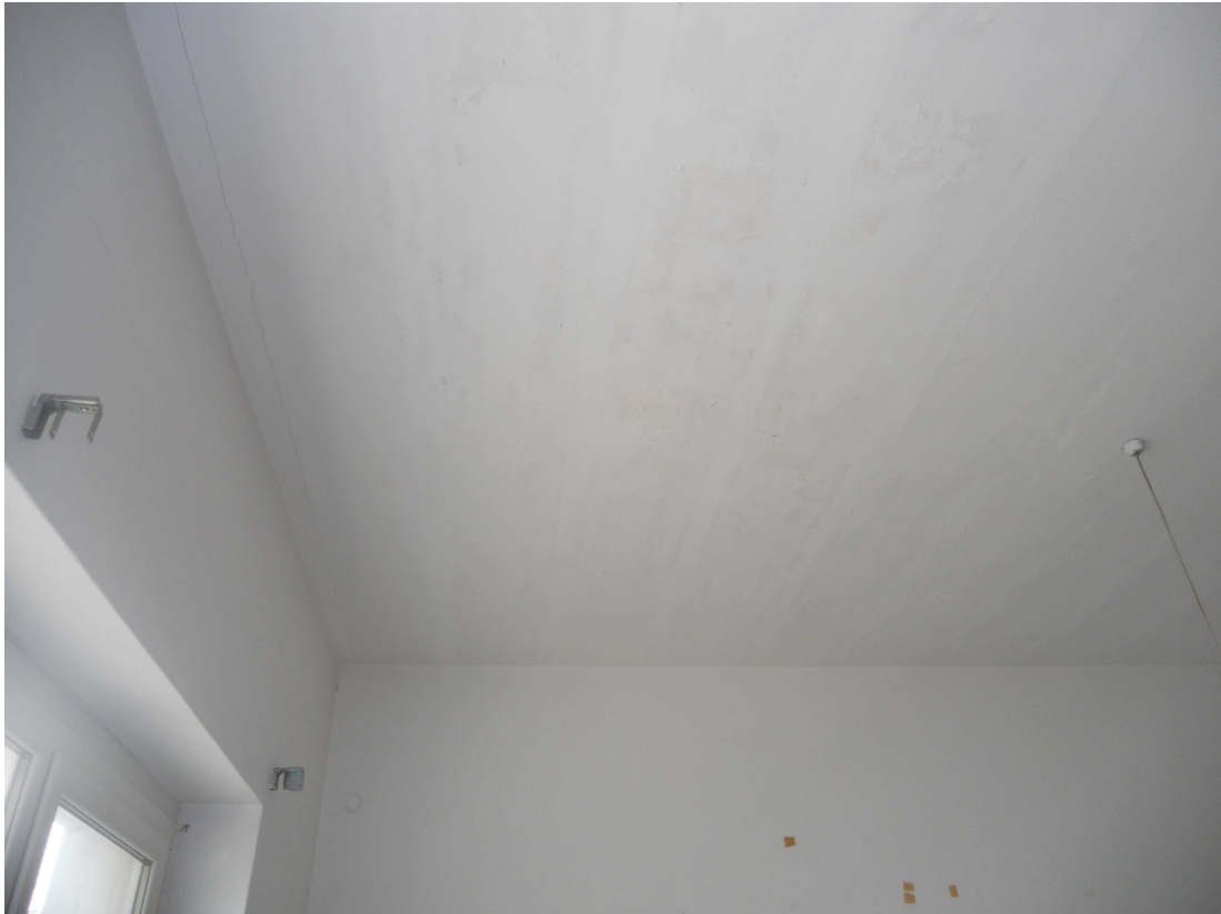
- Distacco di intonaci sulle pareti laterali e soffitto del Locale 11 -
