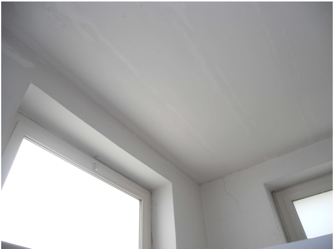
- Distacco di intonaci sulle pareti laterali dei Locali 16-17-18-19 -
