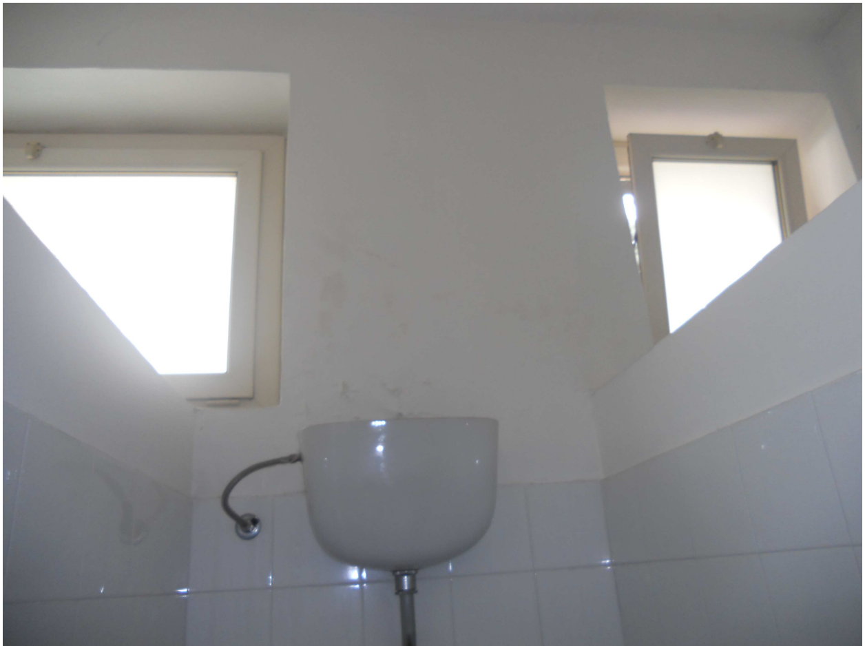
- Rifacimento rivestimenti servizi igienici -
