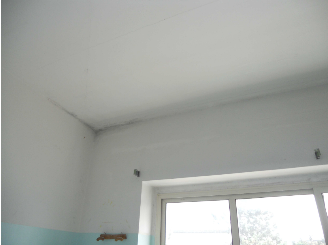
- Distacco di intonaci sulle pareti laterali e soffitto del Locale 13 -
