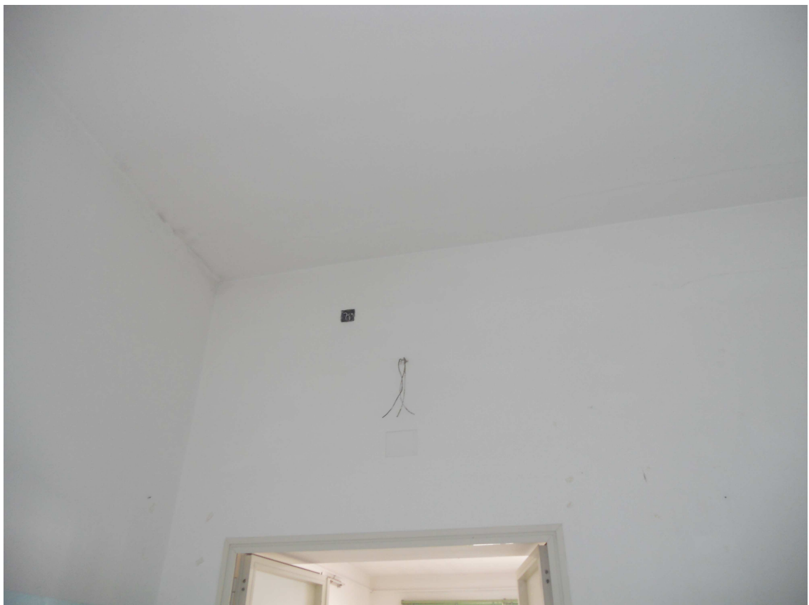
- Distacco di intonaci sulle pareti laterali e soffitto del Locale 12 -
