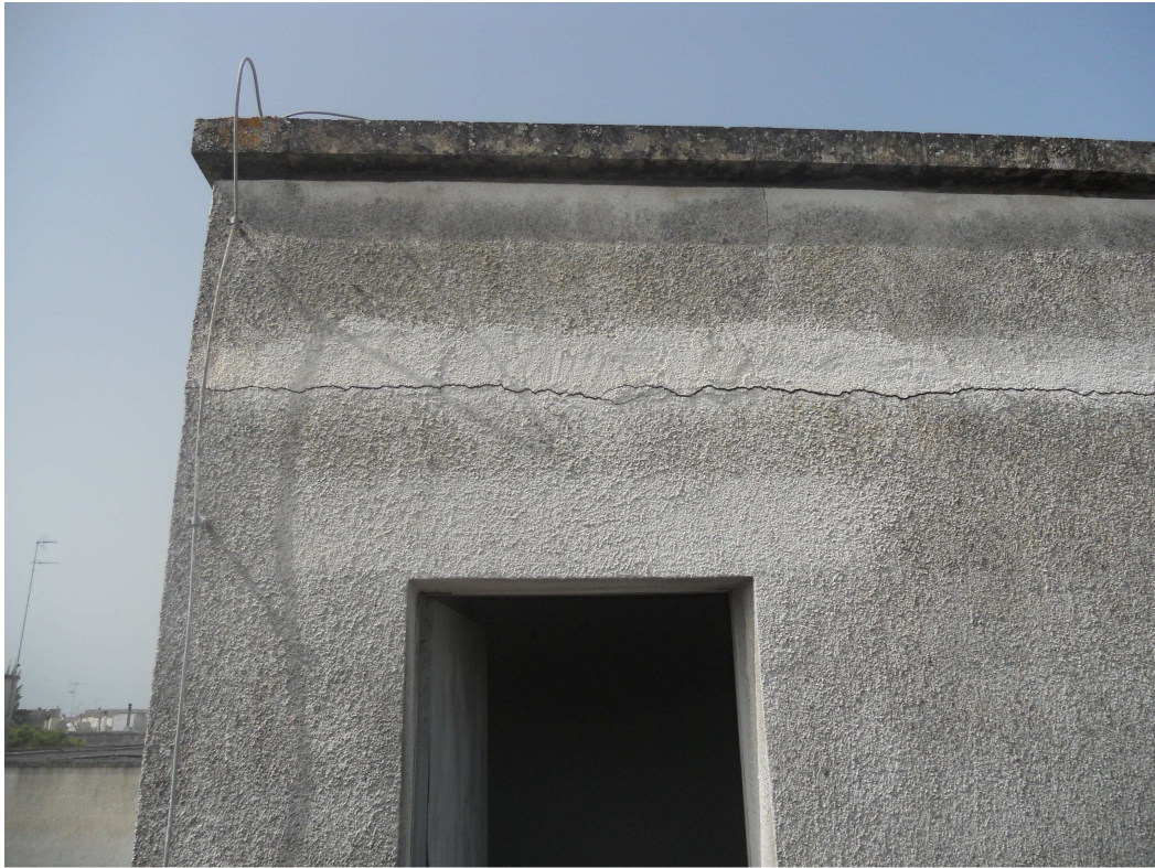
- Distacco di intonaci e micro-fessurazioni sulle pareti esterne del vano scala - Locale 20 -
