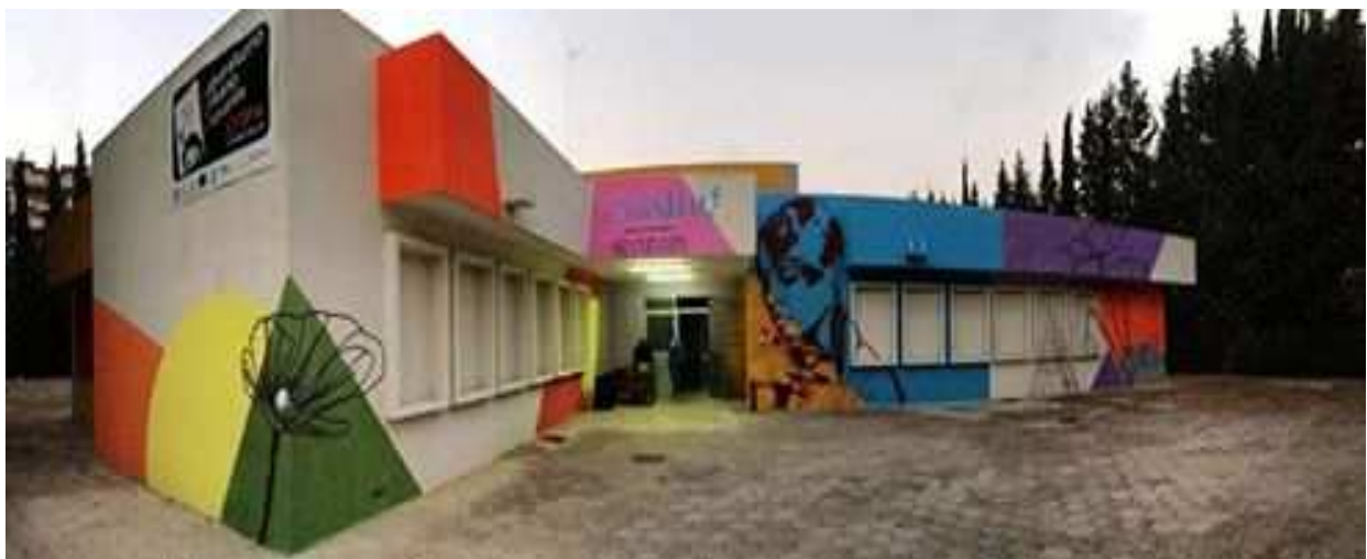
VISTA DALL'ESTERNO DELL'EDIFICIO OGGETTO DI INTERVENTO
