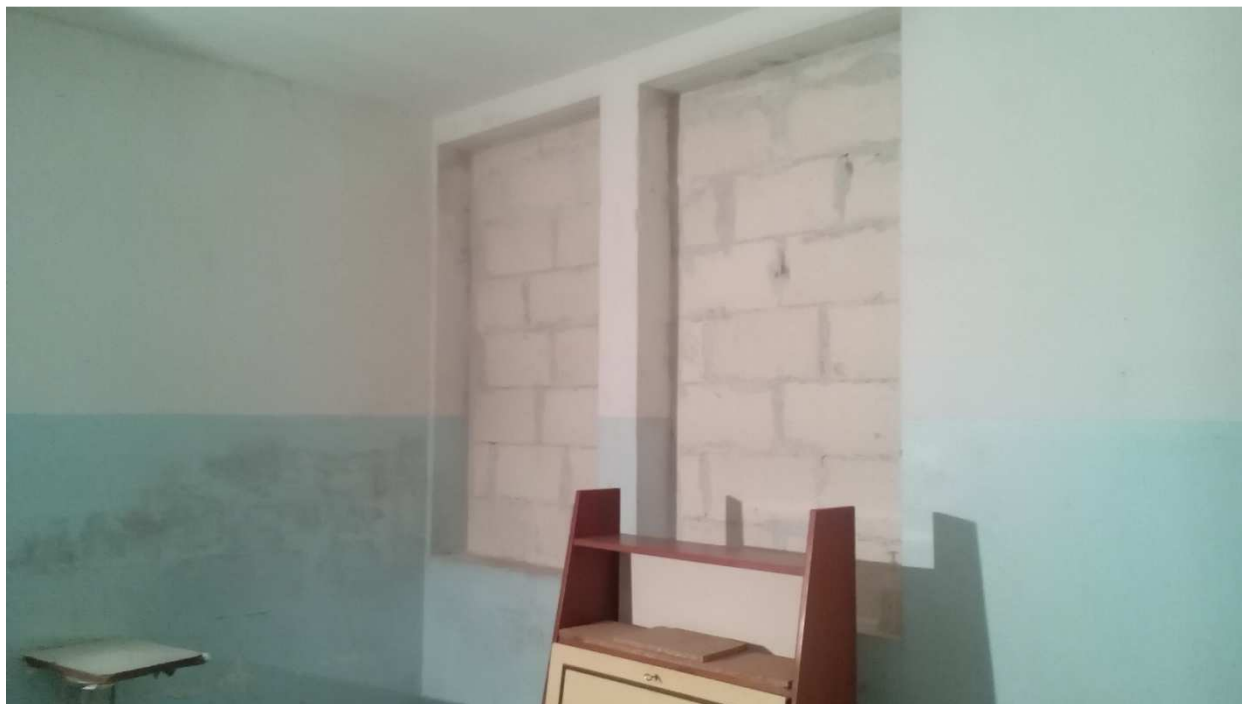
VISTA DI UN VANO INTERNO DELL'EDIFICIO OGGETTO DI INTERVENTO
