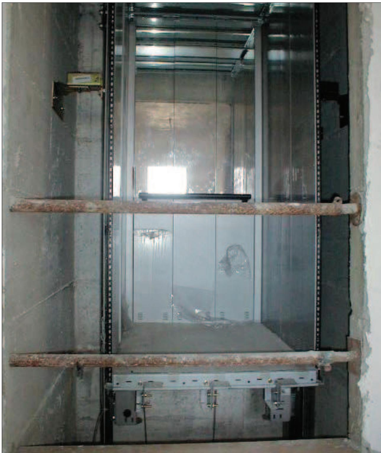
Struttura provvisoria della cabina di un ascensore. La struttura è utilizzata come piattaforma di lavoro.
