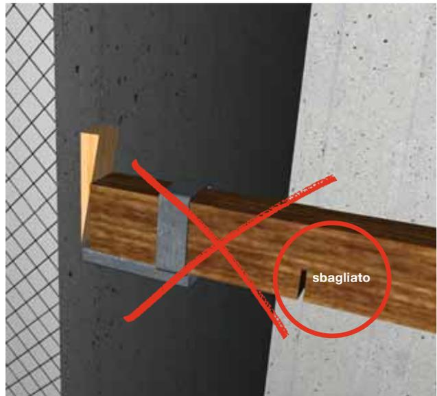
**2** Travetto che presenta un danno meccanico. I travetti che presentano simili danni non devono essere assolutamente usati. Anche per i travetti corti occorre usare solo legno di qualità controllata.
