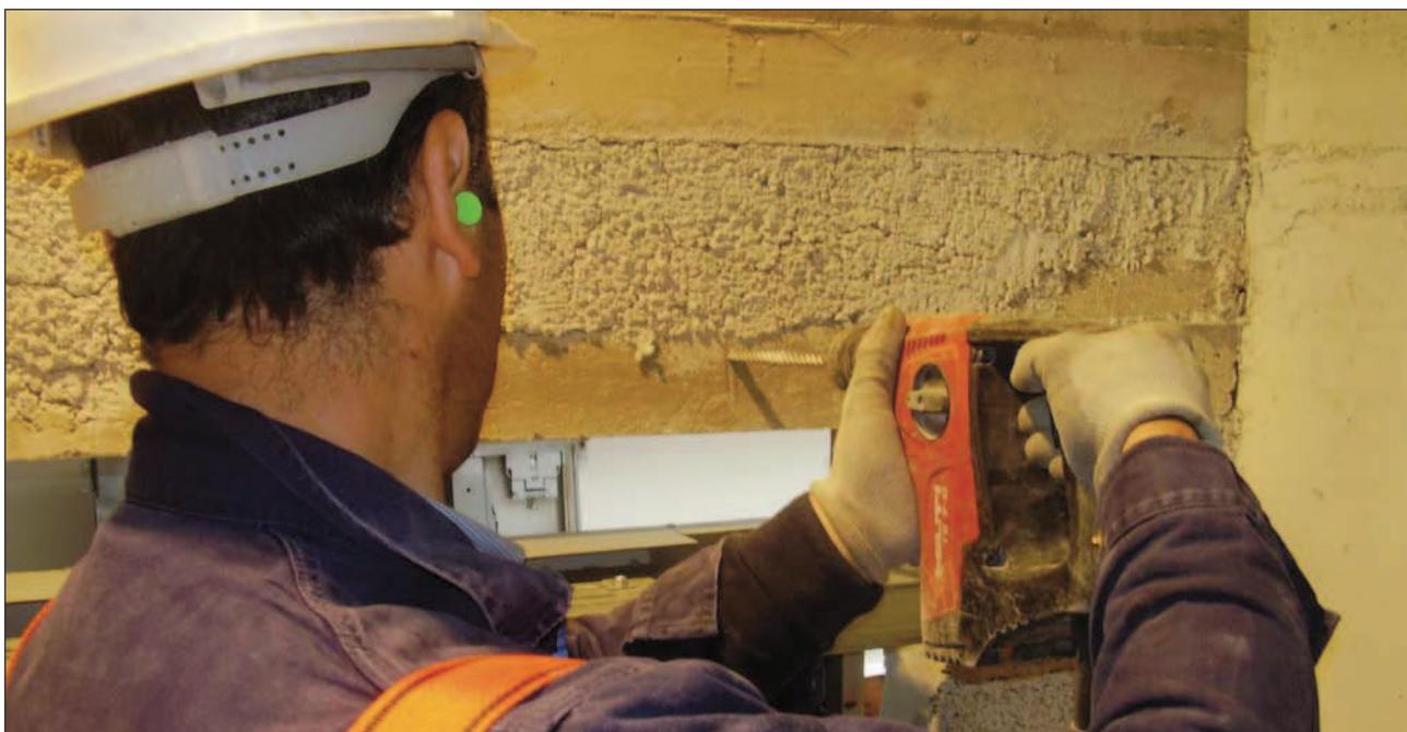
**Esecuzione di un foro nel cemento armato. Operatore con inserti di protezione auricolare**
