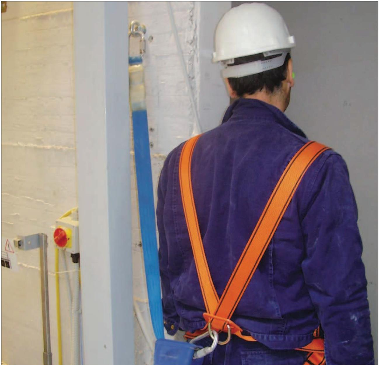
Sistema di arresto caduta con sistema retrattile e con punto di ancoraggio all'altezza dell'operatore
