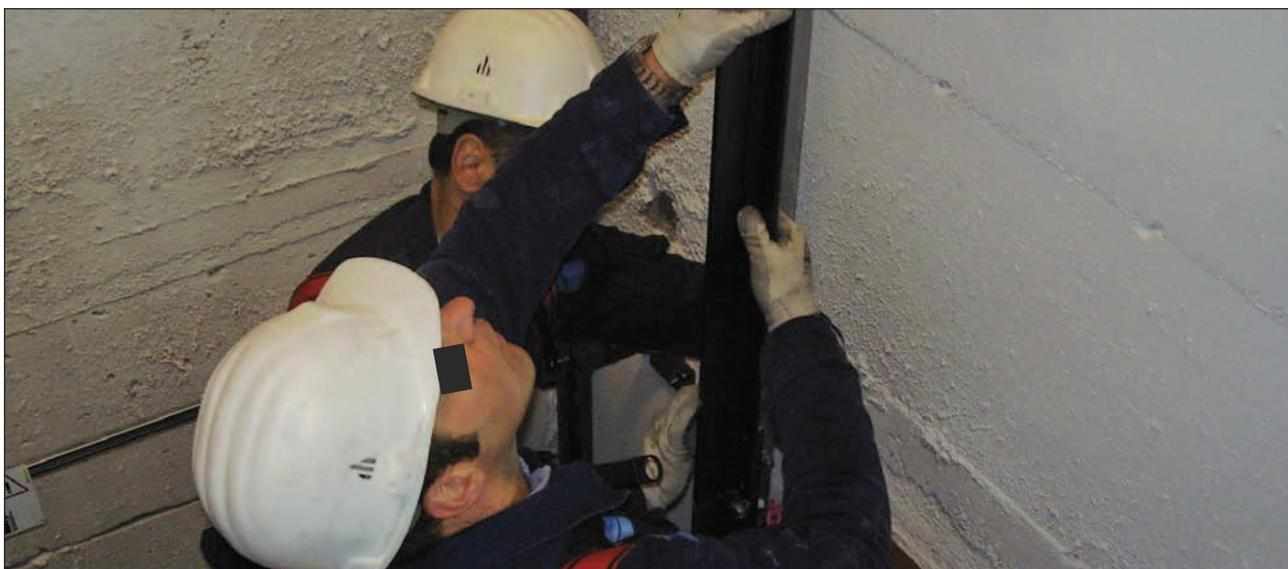
Allineamento di un elemento di guida prima del fissaggio
