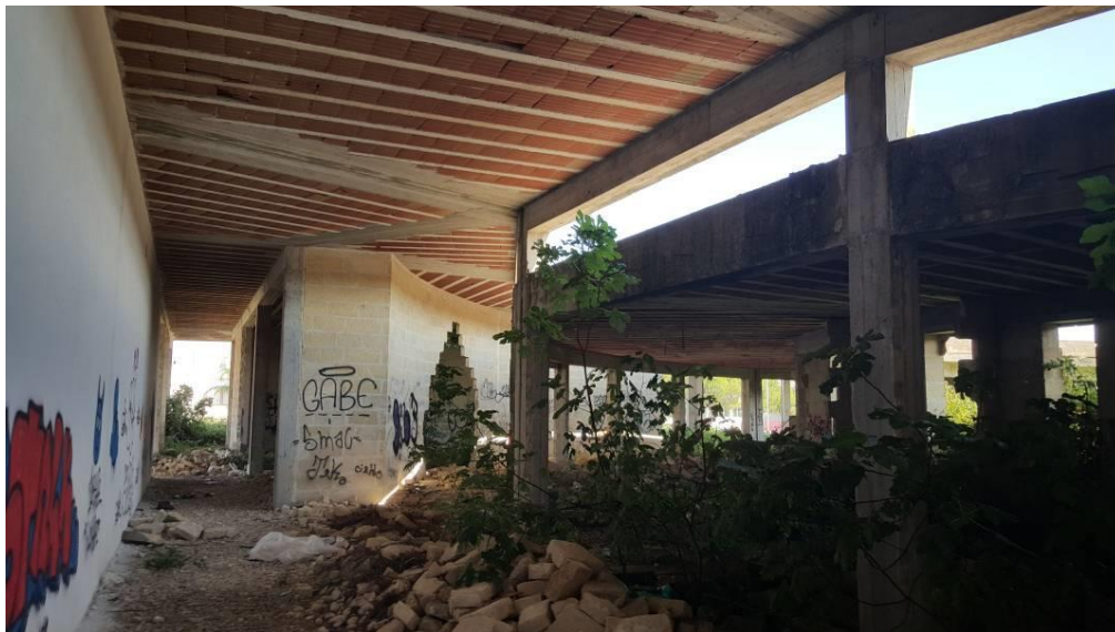
Vista interna in corrispondenza della parte ristrutturata (a sinistra)
