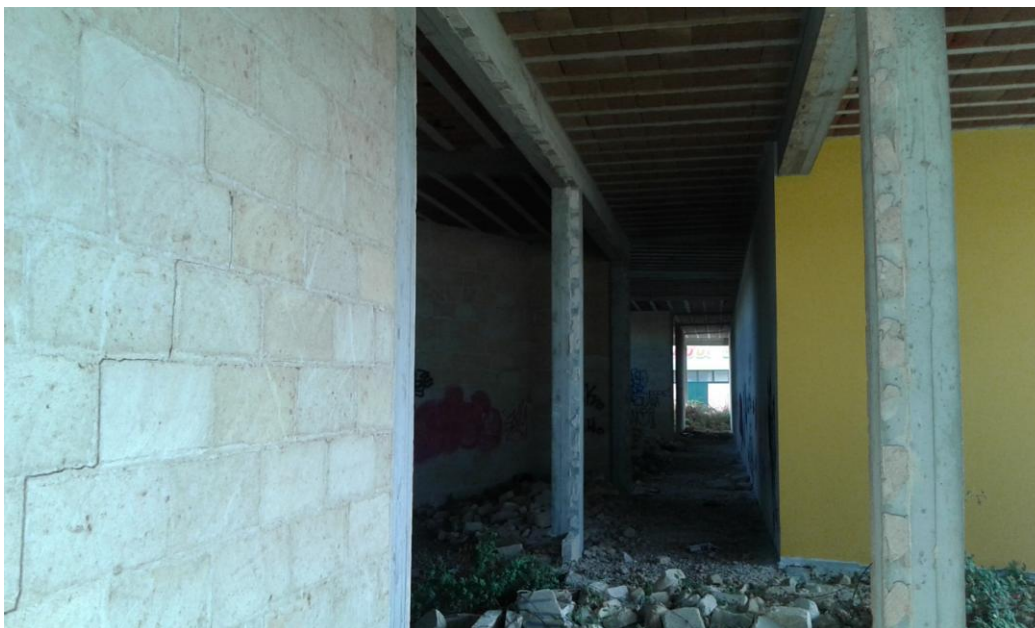
Vista interna in corrispondenza della parte ristrutturata (a destra)
