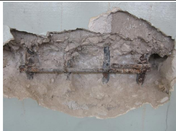
Scarificazione eseguita sul pilastro A24.
