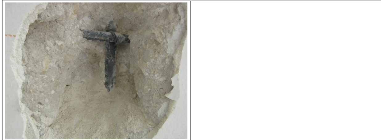
Scarificazione eseguita sul pilastro M05.
