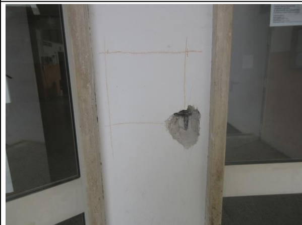
Individuazione del pilastro e tracciamento armature.
