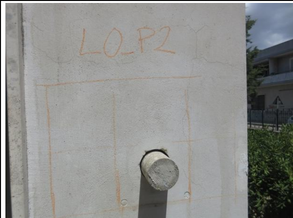
Prelievo di campione di calcestruzzo dal pilastro A22.
