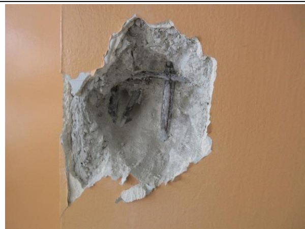
Scarificazione eseguita sul pilastro I08.
