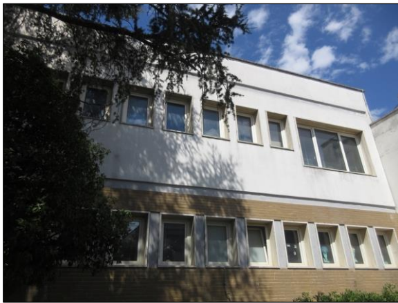
Foto n°5-6 - Particolare del fronte realizzato da pilastri in muratura.
