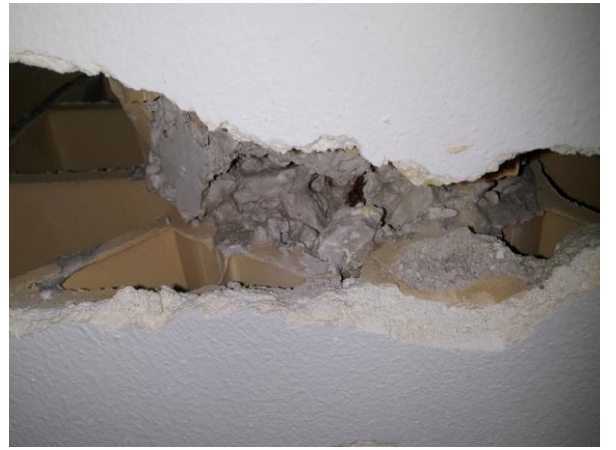
Particolare dell'elemento portante gettato in opera del solaio.
