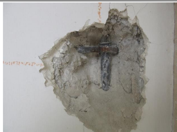
Scarificazione eseguita sul pilastro C06.
