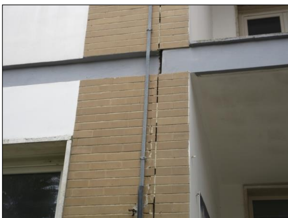
Foto n°2 - Giunto non efficace sismicamente tra US1 e US2.
