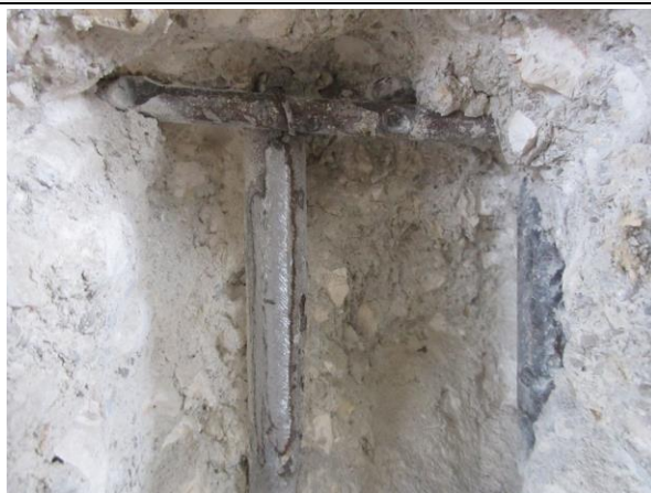
Scarificazione eseguita sul pilastro D13.
