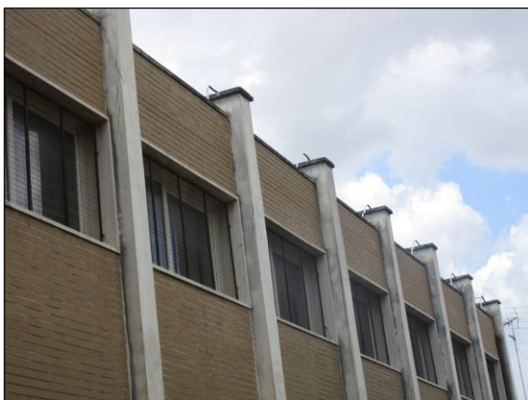
Foto n°7 - Particolare della facciata fronte Via Fatima dell'US4 caratterizzata dalla presenza di pilastri tozzi.
